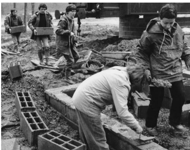
Construction de l'Orient Express Hôtel, photographie Michel Benichou
