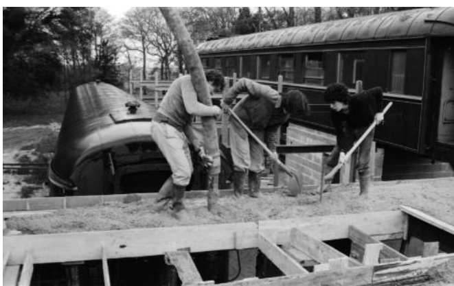
Construction de l'Orient Express Hôtel, photographie Marc Jouanin
